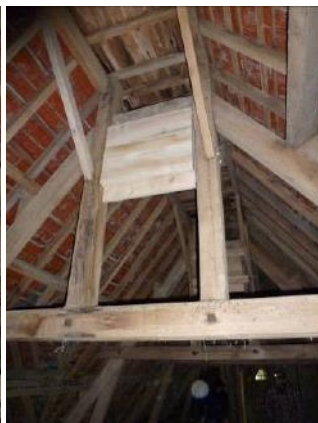
Après travaux, 2 gîtes doubles ont été installés sur la charpente (espaces de 3 et 4 cm). Si les Grands Rhinolophes ne reviennent pas, les espèces appréciant les espaces restreints peuvent aussi trouver leur bonheur dans ce comble
