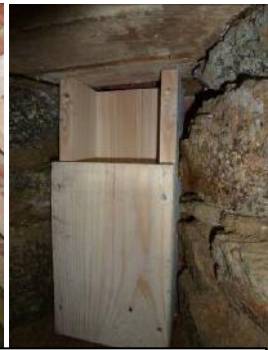
Après travaux, à gauche obscurcissement des tuiles transparentes avec des planches et mise en place d'une chicane sur la meurtrière
