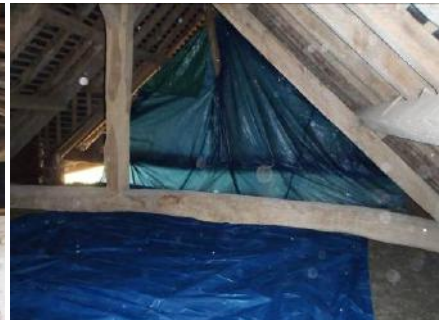
Après travaux, deux bâches ont été installées pour fermer la partie comble et pour protéger le sol.
