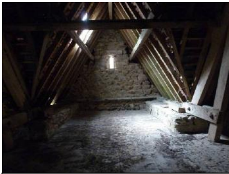
Avant travaux, le comble est lumineux et perméable aux prédateurs (meurtrière)
