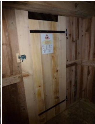
Après travaux, une porte a été réinstallée séparant la partie du clocher de la partie comble. L'ouverture dans la porte (chiroptière) permet le passage des chauves-souris en plein vol mais ne laisse pas le passage aux prédateurs.
