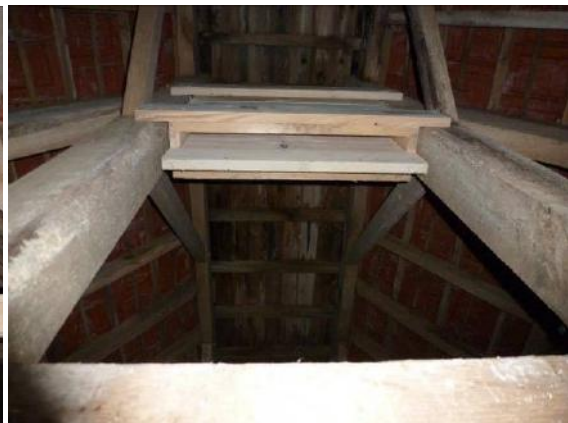
Après travaux, 2 gîtes doubles ont été installés sur la charpente (espaces de 3 et 4 cm). Si les Grands Rhinolophes ne reviennent pas, les espèces appréciant les espaces restreints peuvent aussi trouver leur bonheur dans ce comble
