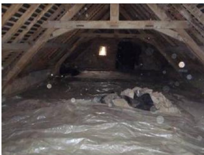
Avant travaux, le comble ouvert sur le garage
