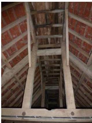
Avant travaux, charpente du comble
