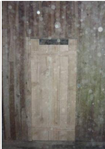
Après travaux, une porte a été réinstallée séparant la partie du clocher de la partie comble. L'ouverture dans la porte (chiroptière) permet le passage des chauves-souris en plein vol mais ne laisse pas le passage aux prédateurs.
