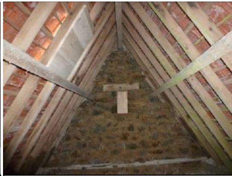
Après travaux, à gauche obscurcissement des tuiles transparentes avec des planches et mise en place d'une chicane sur la meurtrière
